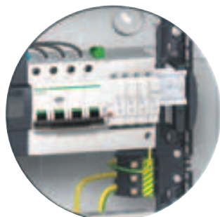
Razdelilna omara Pragma: ozemljitveni blok sestavlja 1x podpora in 1x sponke.
