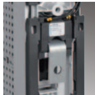
Vgrajeni tokovni transformatorji
